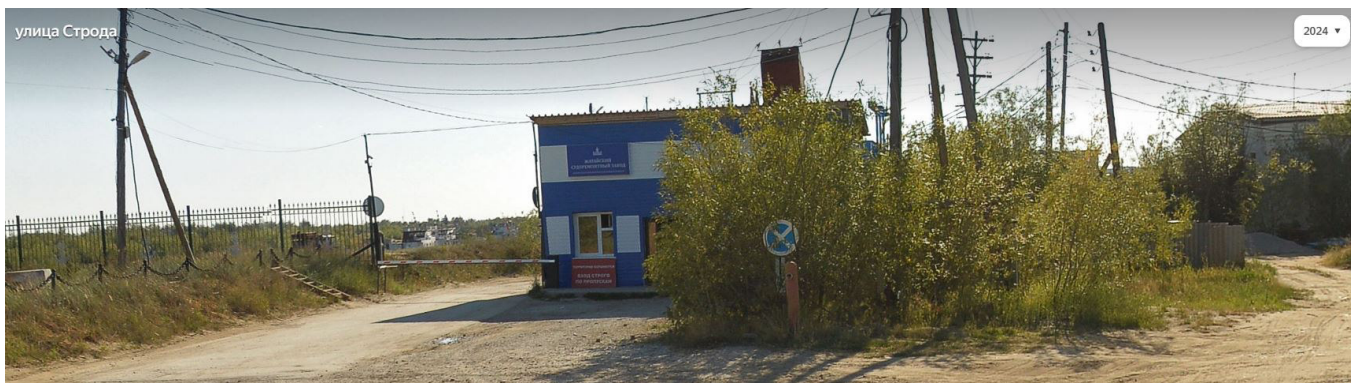
Фото 14 - Здание ближайшего подразделения пожарной охраны: Пожарной части № 12 Отряда № 40 Государственной противопожарной службы Республики Саха (Якутия) по охране Муниципального образования Городской округ «Якутск»
