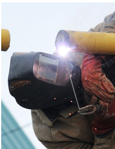
Фото 11 - Установка заглушки на патрубок остающегося в эксплуатации трубопровода
