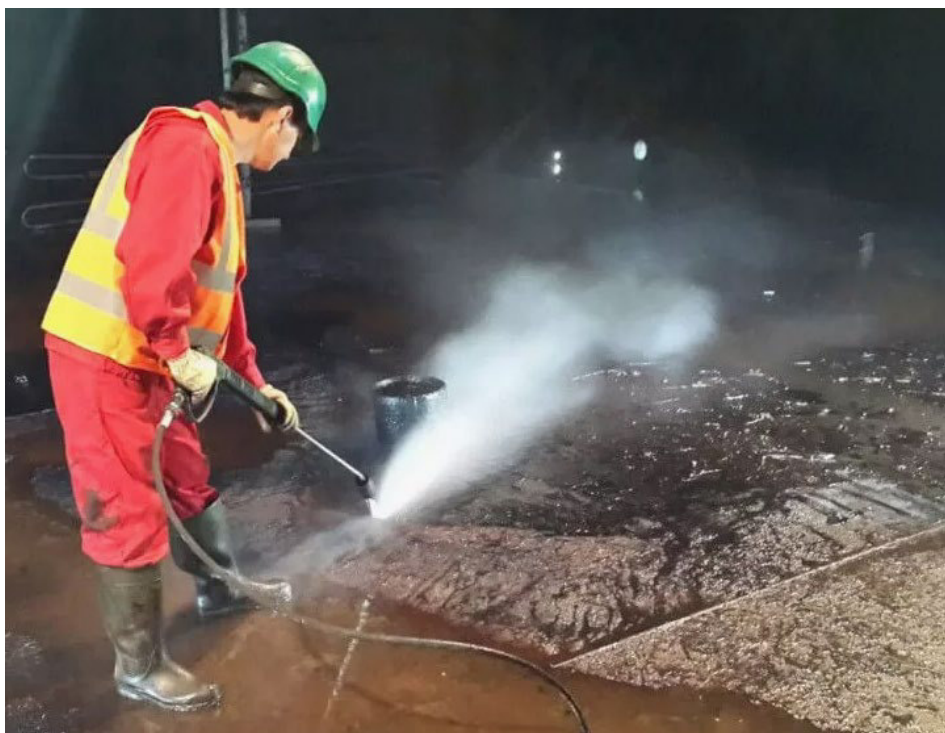
Фото 6 - Пропаривание внутренней поверхности вертикального резервуара хранения темного нефтепродукта
