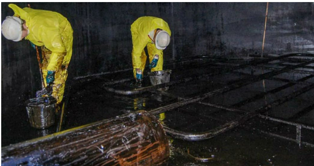
Фото 5 - Зачистка ручным методом дна вертикального резервуара хранения темного нефтепродукта
