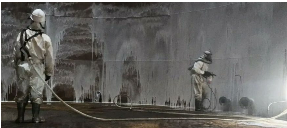
Фото 7 - Промывка внутренней поверхности вертикального резервуара хранения темного нефтепродукта
