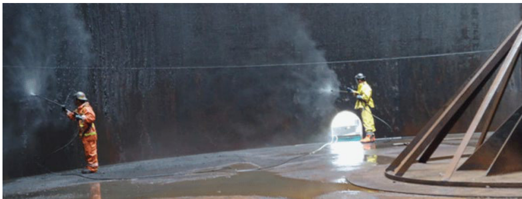
Фото 5 - Зачистка ручным методом дна вертикального резервуара хранения темного нефтепродукта
