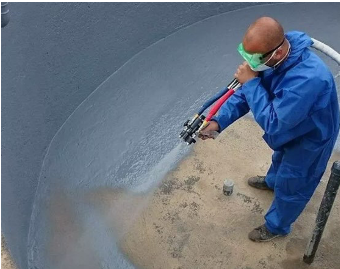
Фото 8 - Нанесение рекомендуемого настоящей проектной документацией ингибитора коррозии на полностью подготовленную внутреннюю поверхность вертикального резервуара хранения нефтепродукта
