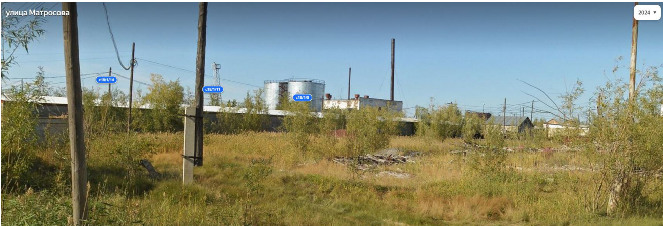
Фото 3 - Ограждение территории технически перевооружаемого опасного производственного объекта АО «Саханефтегазбыт», вид с ул. Матросова пос. Жатай
